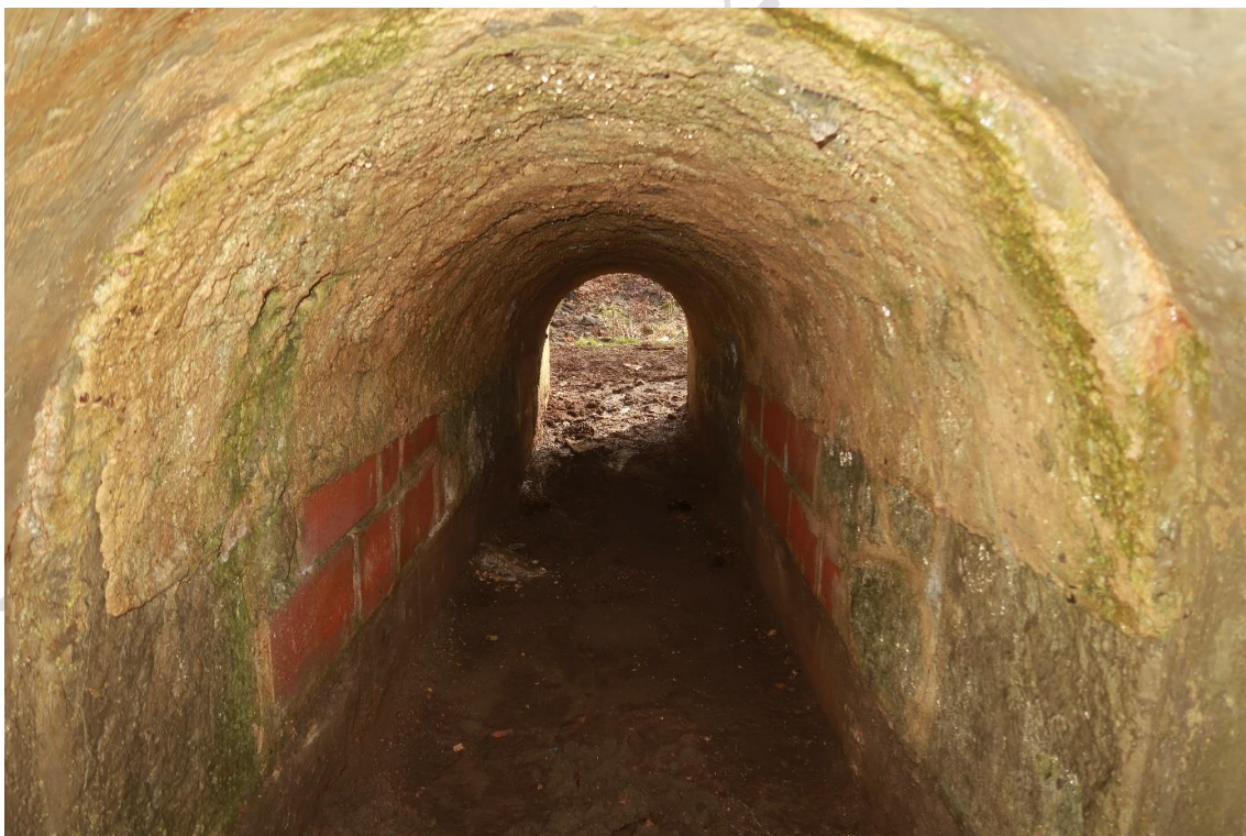
Foto 6: Pohled do tělesa propustku, zdivo převážně omítnuto, převládá zdivo ze sedimentárních hornin (pískovce, slínovce aj.), zdivo dříve lokálně vyspraveno cihlami, konstrukce zasažena vysokou vlhkostí, místy pokryto řasou
