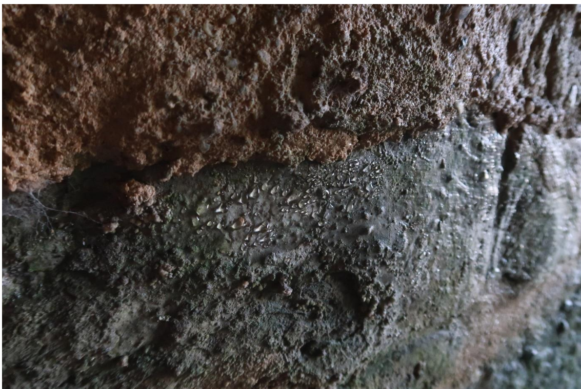
Foto 11: Detail povrchu zdiva, zdivo zcela saturováno vodou, na povrchu kapky
