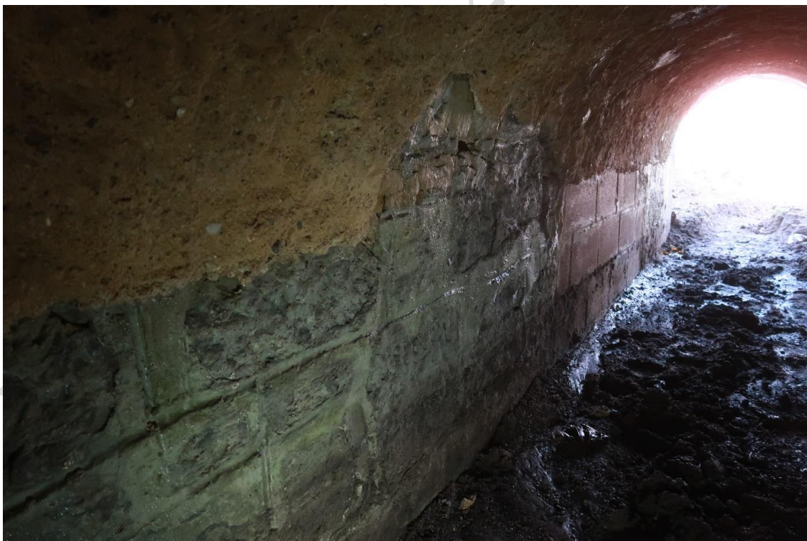
Foto 10: Stěny propustku, místy řádkové zdivo z pískovce (odhalené), klenba omítnuta, převážně ze zvětralé opuky
