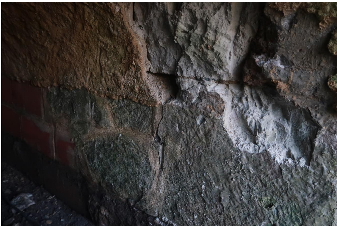
Foto 9: Trhliny se lokálně propisují i do stěn propustku (šíře 1,0 až 1,5 mm), obě strany, poloha trhliny cca 1,0 až 1,5 m od čelní zdi
