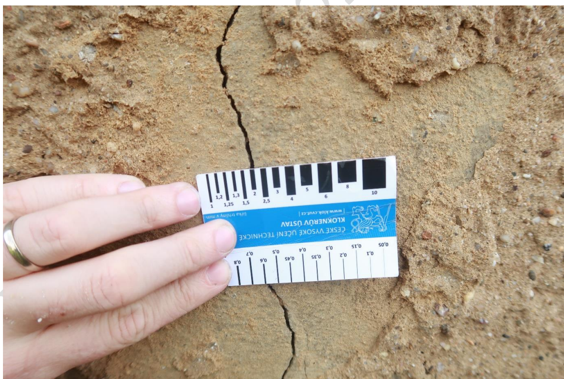
Foto 4: Detail z fotografie 3 po odstranění svrchní vrstvy omítky, šířka trhliny až 2,0 mm
