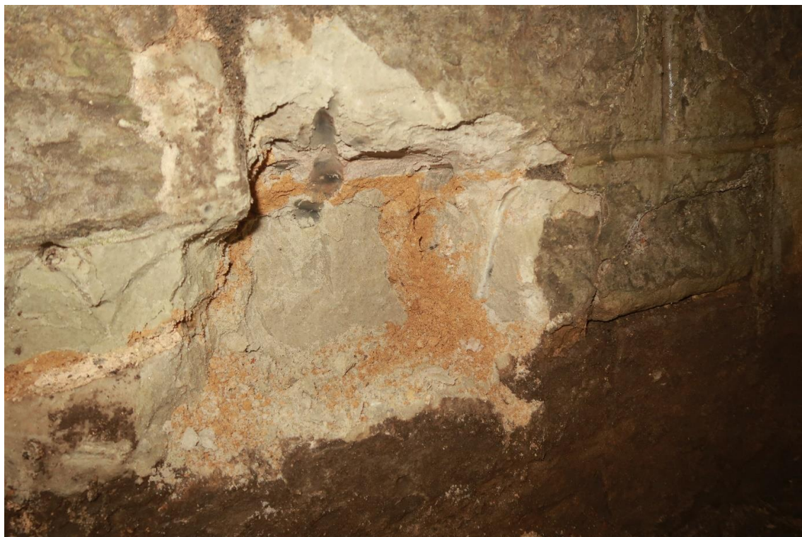
Foto 17: Místo po odběru vzorku 1 (pískovec), zdivo zcela mokré, místy se drolicí, malta velmi nízké pevnosti, částečně s vyluhovaným pojivem, cca v 1/3 délky propustku
