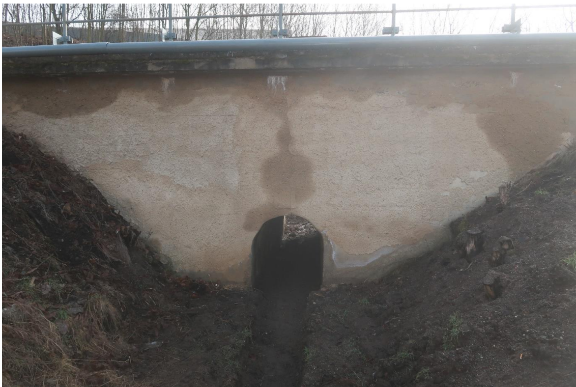
Foto 1: Pohled na vstup do propustku (směrem od ulice Ouvalova), čelní zeď mokrá, ve vrcholu klenby svislá trhlina
