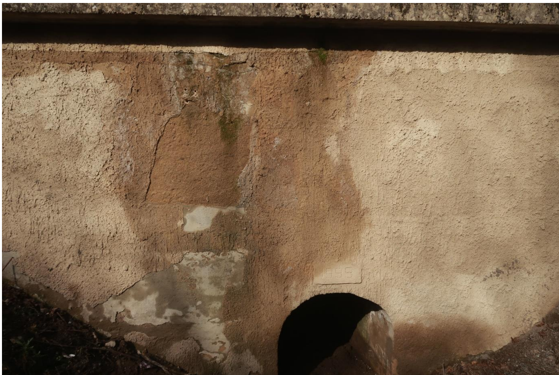
Foto 25: Odběr solí, vzorek VZ3, oblast pod římsou na čelní zdi (druhý pohled), lokálně výluhy mírně šedivé barvy + biologické nánosy, návrt z hloubky 0-30 mm (omítka/malta)
