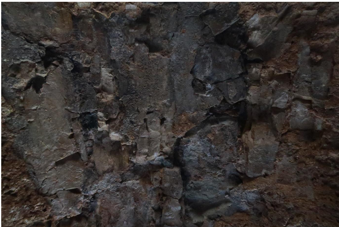
Foto 13: Pohled na vrchol klenby, jednotlivé prvky narušeny procesem zvětrávání
