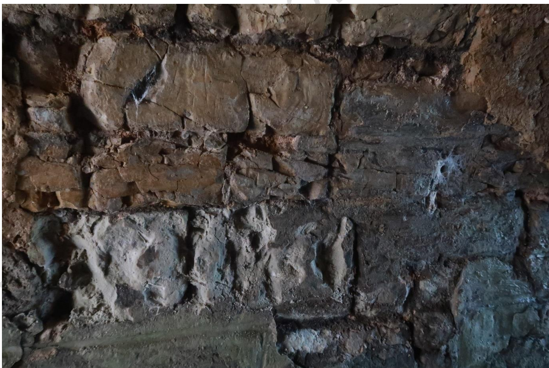
Foto 12: Pohled na rozhraní stěny a klenby propustku cca v 1/2 délky, klenba převážně z opuky (slínovce), zdivo výrazně narušeno trhlinami, stěny z pískovce
