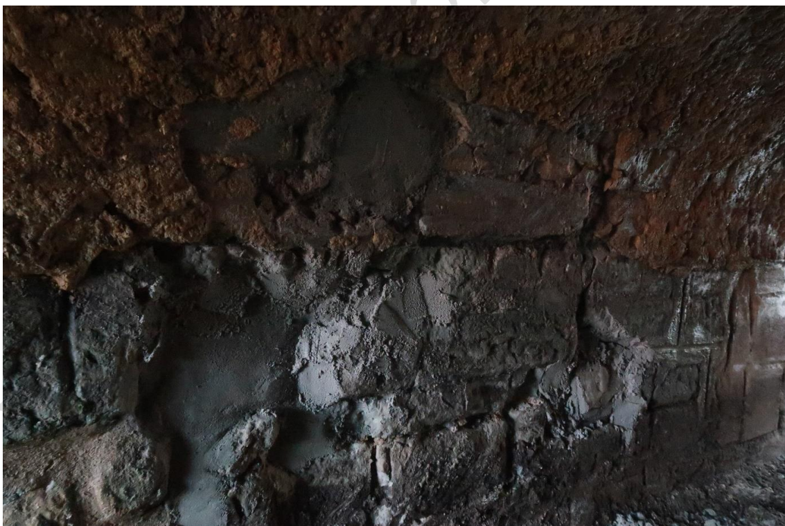
Foto 22: Sanace zdiva po odběru vzorku 2 a 3, zdivo částečně dozděno, spáry vyplněny
