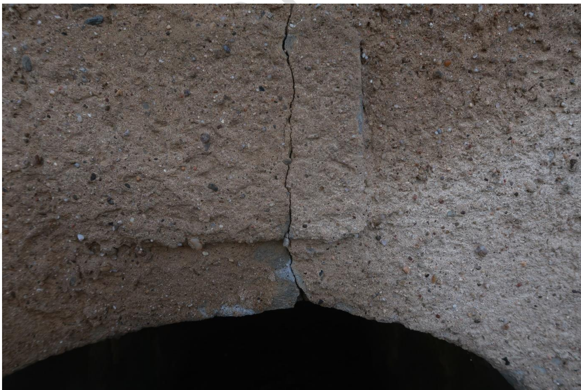
Foto 2: Vrchol klenby (oblast klenáku), svislá trhlina od vrcholu klenby až k římse
