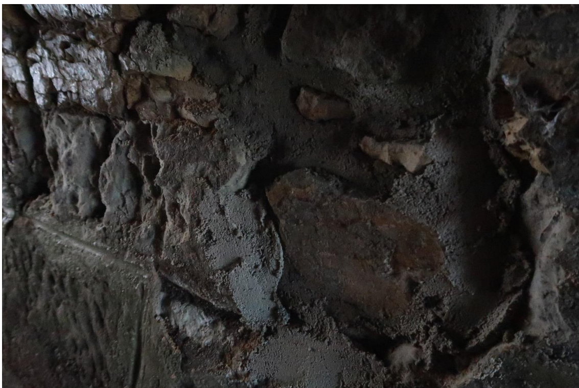
Foto 21: Sanace zdiva po odběru vzorku 1, zdivo částečně dozděno, spáry vyplněny
