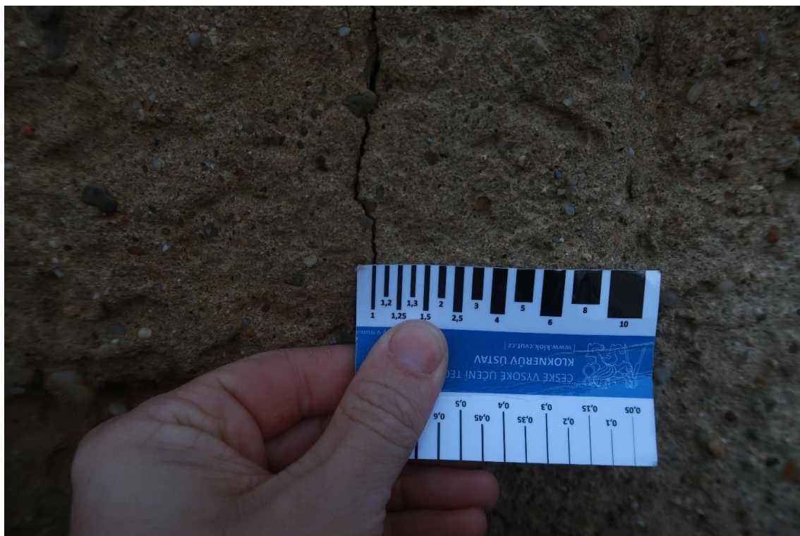
Foto 3: Vrchol klenby (oblast klenáku), trhlina šíře cca 1,0 mm
