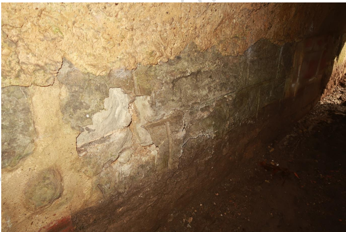
Foto 14: Povrch pískovce místy degraduje (vlivem vlhkosti a mrazu), odpadávají svrchní vrstvy
