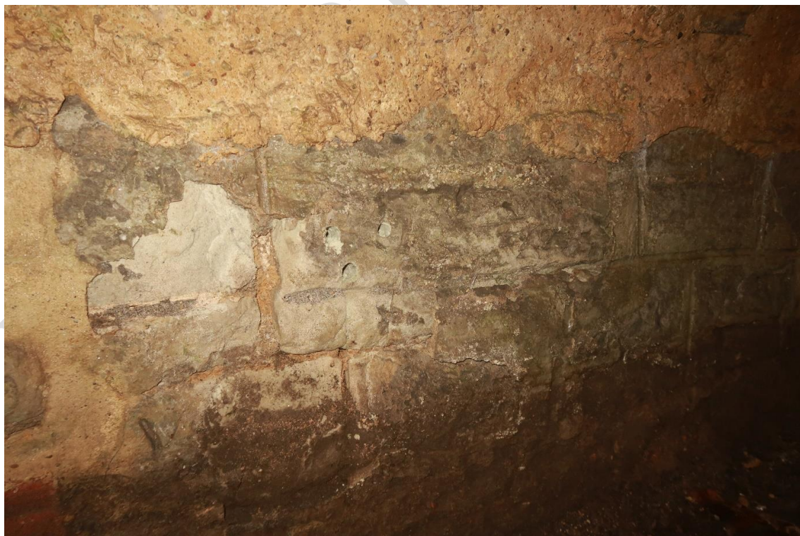
Foto 24: Odběr solí, vzorek VZ2, stěna propustku cca 1/2 délky, odběr z hloubky 0-30 mm (pískovec)
