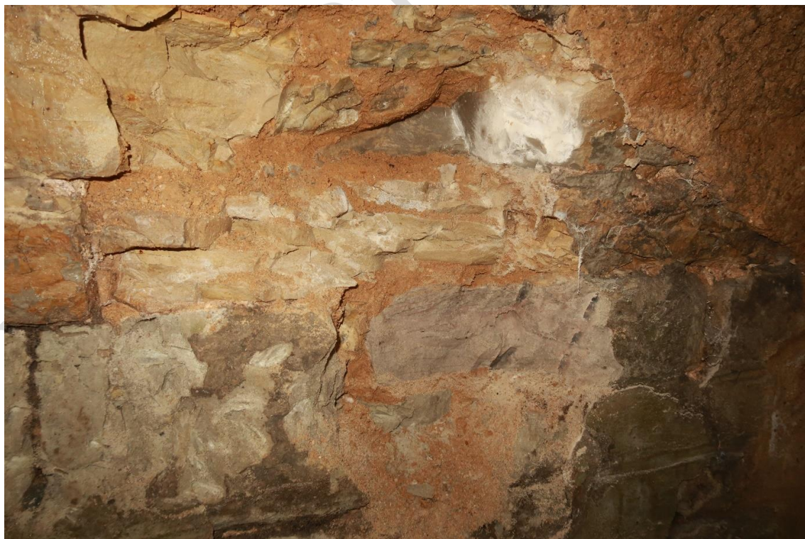
Foto 18: Místo odběru vzorku 2 (pískovec) a 3 (slínovec=opuka), cca ve 2/3 délky propustku, opuka silně narušena, odebrán jediný možný celistvý kus
