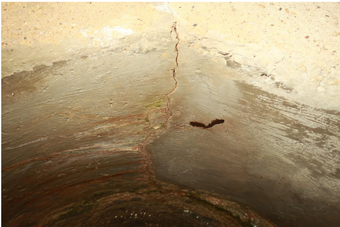
Foto 7: Pohled na vrchol klenby za vstupem, trhlina šířky 1,0 až 2,0 mm
